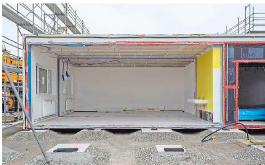
Die Pavillons werden auf Fundamenten aneinandergereiht.
