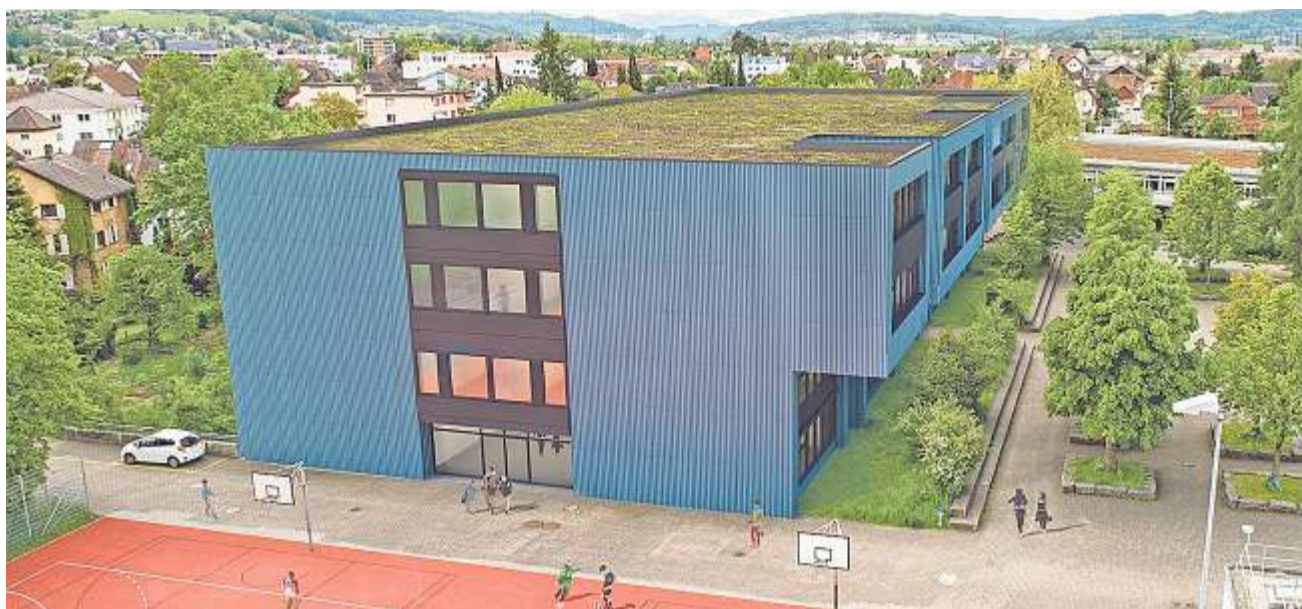
Die geplante Sanierung und Aufstockung des blauen Oberstufenschulhauses in Oberentfelden trägt zur Schaffung von dringend benötigtem Schulraum bei. Das Bauprojekt erfüllt zudem die Vorgaben des Lehrplans 21 und wird dem verdichteten Bauen gerecht.
