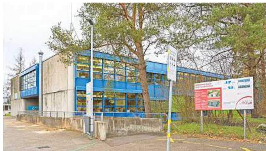
Dank zweigeschossiger Aufstockung samt Sanierung bietet das altehrwürdige blaue Oberstufenschulhaus bald mehr vom dringend benötigten Schulraum an der Kreisschule Entfelden. BILD: ZVG
